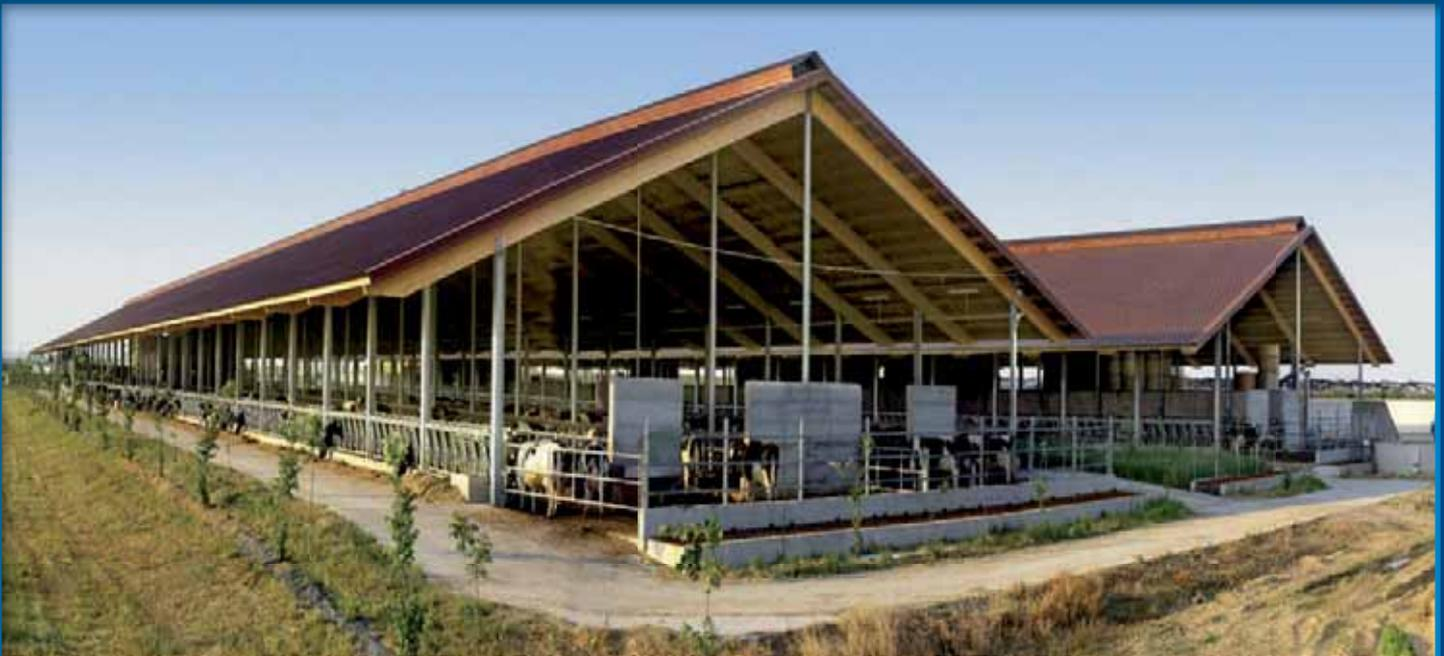
**Paneles de fibra de vidrio para cubiertas de techos y revestimientos para paredes en criaderos y establos.**
