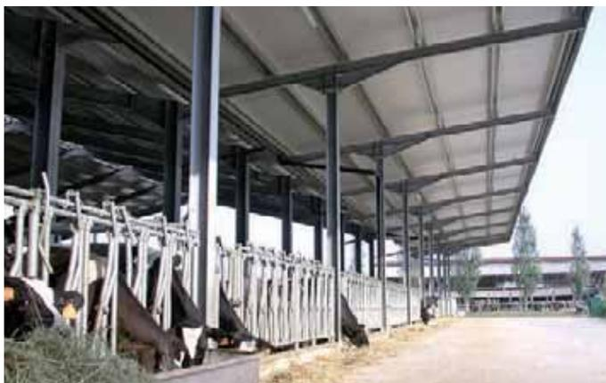
La atmósfera corrosiva en los criaderos, afecta continuamente todas las superficies, por ello un número cada vez mayor de instalaciones exigen componentes protegidos con fibra de vidrio (paneles internos, chimeneas y cubiertas).
