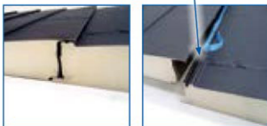
cordón sellante / cordon d'etanchéité / sealing cord
