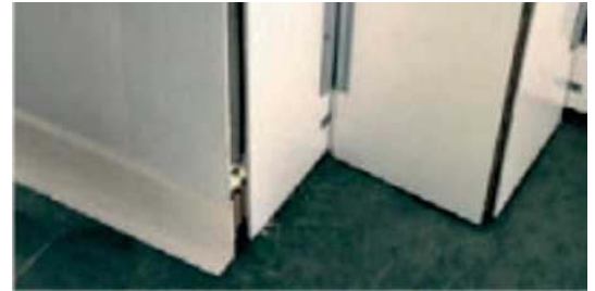
Montaje P.V.C. con perfil sanitario.
